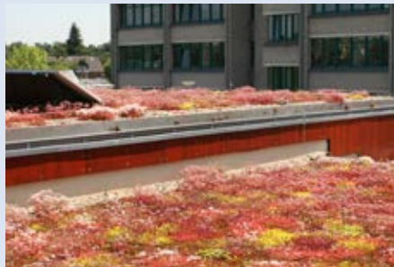
Eine Dachbegrünung mit Mauerpfeffer lässt Flachdächer aufblühen.
